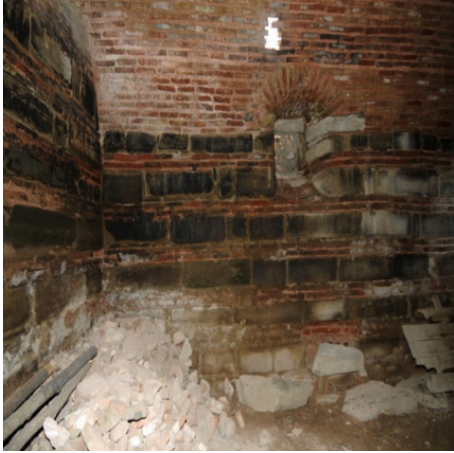
Görsel 152-153. İç Mekân Kubbe, Tonoz Tuğla ve Yonu Taşı Görünüşleri (Ş. Öztürk)
