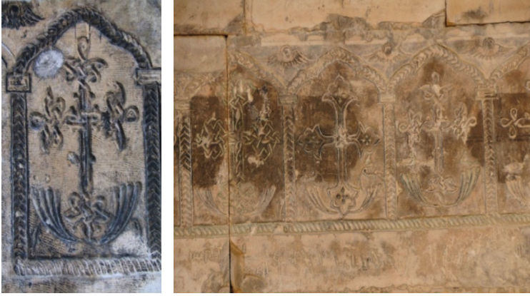
Görsel 145-146. Giriş Revak Beden Duvarı Haçkar Süsleme Görünüşleri (Ş. Öztürk)
