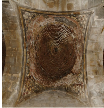
Görsel 152-153. İç Mekân Kubbe, Tonoz Tuğla ve Yonu Taşı Görünüşleri (Ş. Öztürk)
