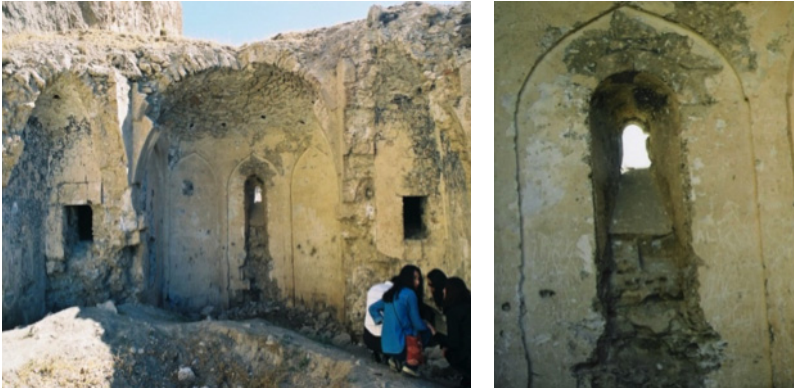
Görsel 229-230. Surp Vardan Kilisesi İç Mekan ve Mazgal Pencere Görünüşleri (Ş. Öztürk)
