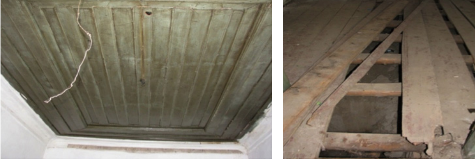
Görsel 357-358. İğdir Evi Tavan ve Taban Ahşap Kaplama Görünüşleri
