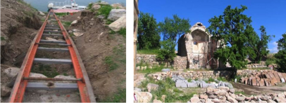
Görsel 63-64. Akdamar Kilisesi Onarım Çalışmaları Görünüşleri (Ş. Öztürk)
