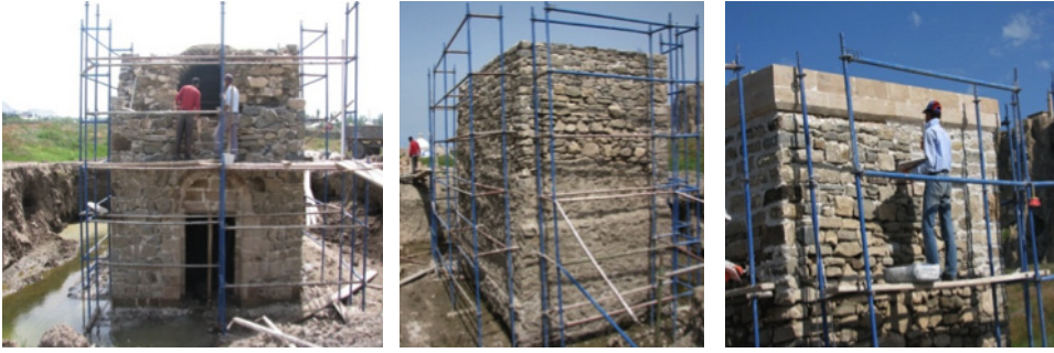
Görsel 279-281. Surp Diziranavor Kilisesi Onarım Görünüşleri (Ş. Öztürk)
