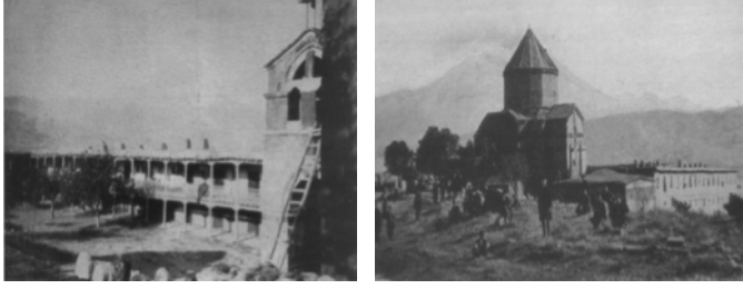
Görsel 5-6. Akdamar Kilisesi Avlu İç ve Kuzeybatı Genel Görünüşleri (Rohrbach-Van”NuK”)
