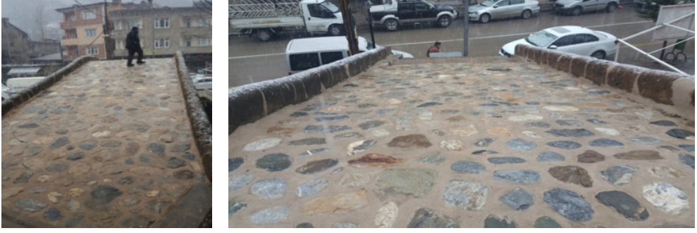
Görsel 386-387. Çatak Merkez Köprüsü Döşeme Görünüşleri (Ş. Öztürk)
