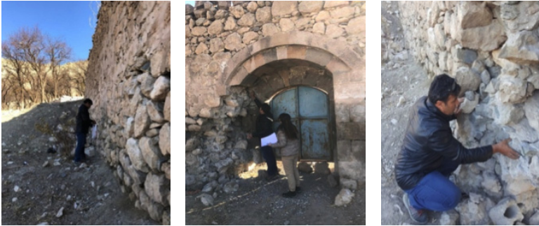
Görsel 329-331. Doğubayazıt Keşişin Bahçesi Harç ve Sıva Numunesi Görünüşleri (Ş. Öztürk)
